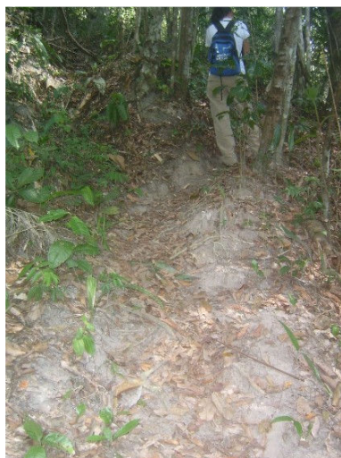
Figura 10: Erosão do solo.
