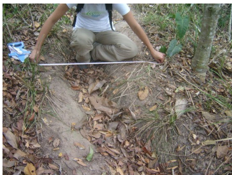
Figura 14: Canal de erosão no leito.
