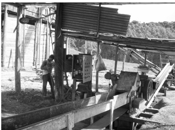
Figura 6. Área da esteira ligada ao silo. Fonte: autores.
